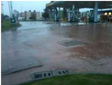
*Fotografía 6. Área y cunetas de recolección sin conexión a tratamiento hacia la carrera 64*
